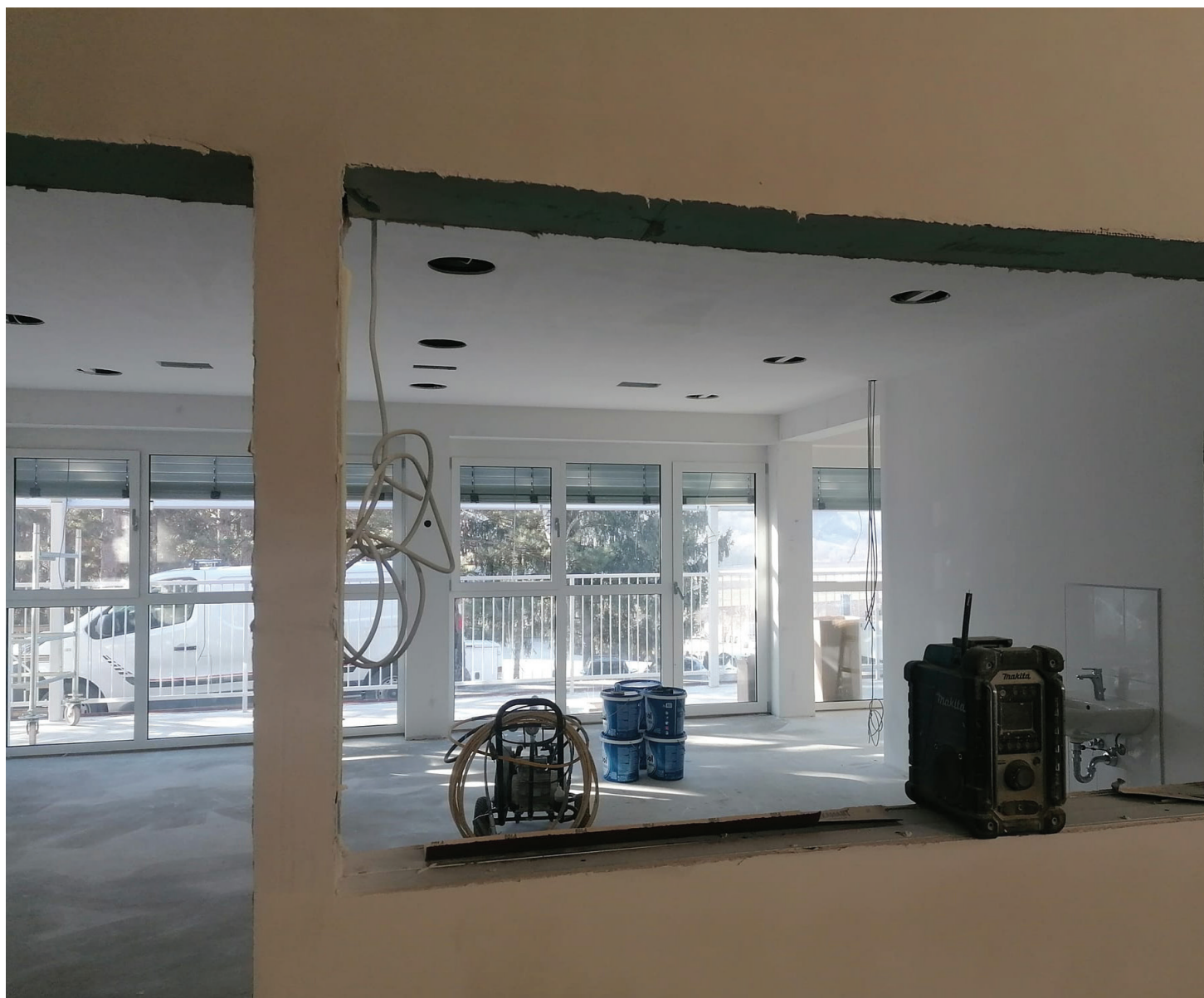
Dela pri izgradnji prizidka k vrtcu v Pristavi pri Mestinju so v zaključni fazi. (Foto: Peter Misja)
